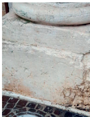
Parziale rimozione biodeteriogeni (alghe-licheni)
