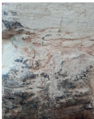
Rimozione scaglie, consunzione
